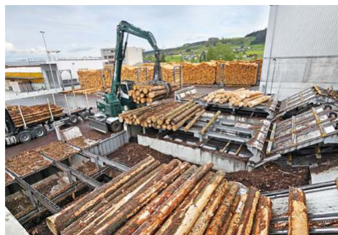
Drei Aufgabedecks stehen für die Kurzholzaufgabe zur Verfügung. Zudem ist hier auch die Zuführung von Langholz bis 22,5 m möglich
